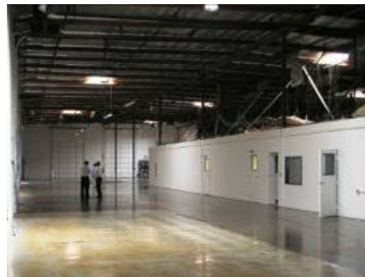
クリーンエリア：工事中
